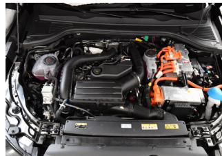
Oranžinės spalvos kabelis variklio skyriuje
